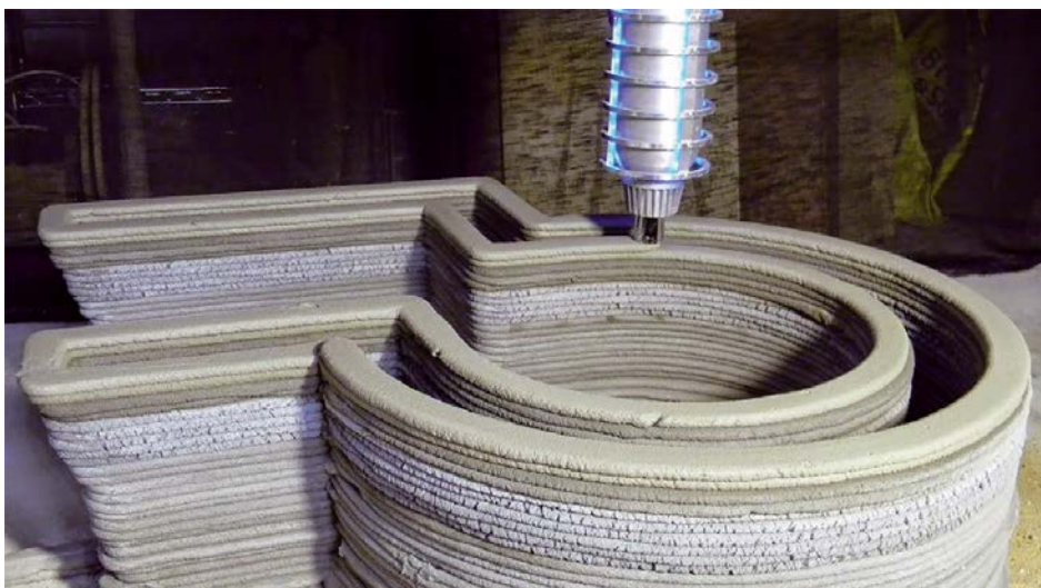
Poraver® jest stosowany jako wypełniacz w druku 3D z lekkiego betonu. Poprawia własności mieszanki i zwiększa grubość i szybkość nakładania warstw.
